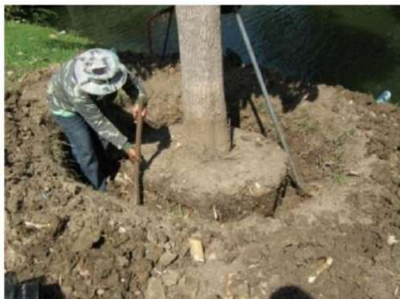
ภาพที่ 6.2-1 ตัวอย่างการขุดดิน ตัดราก และห่อหุ้มตุ้มดินเพื่อขุดล้อมต้นไม้
