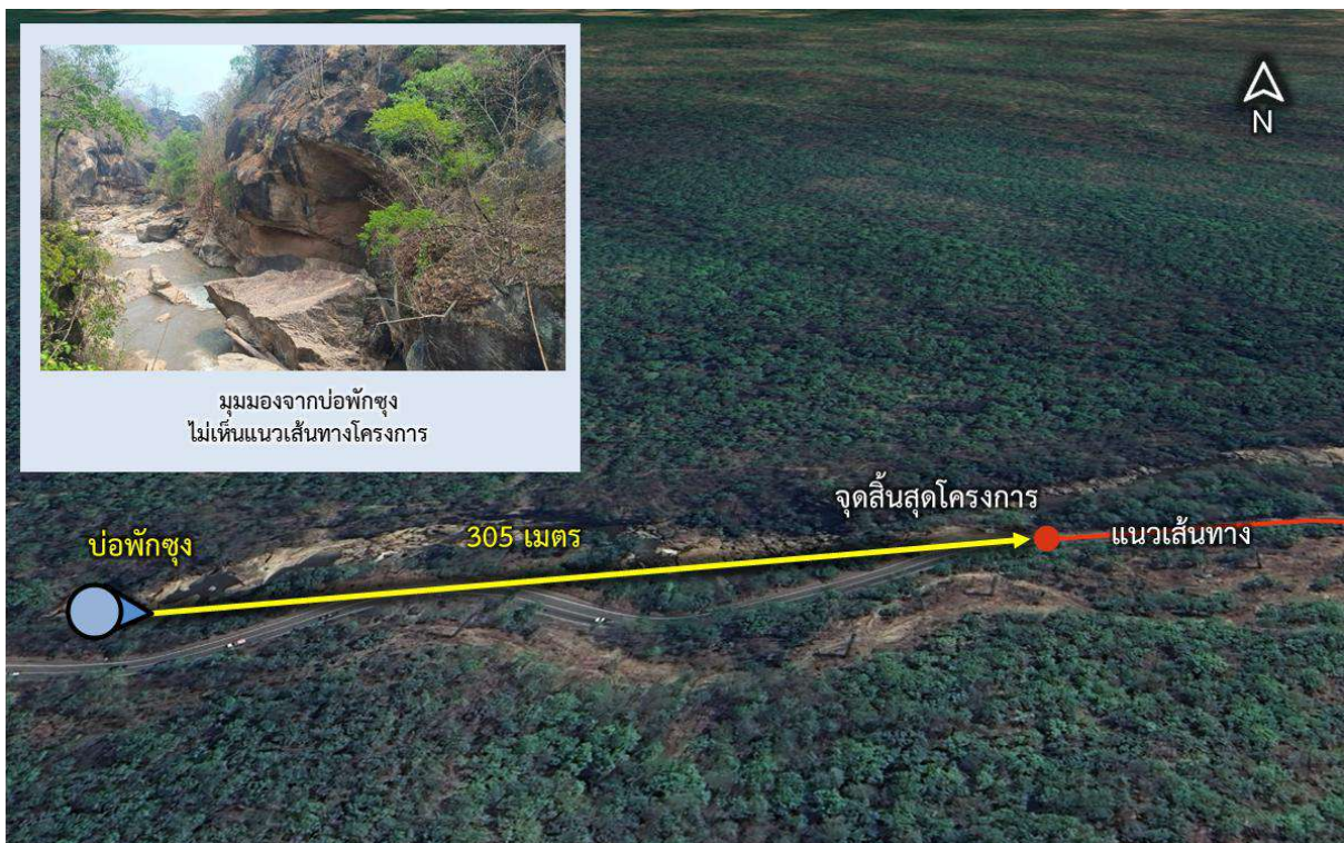
รูปที่ 4.6-3 มุมมองจากบ่อพักซุง
