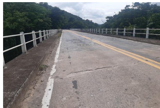
สภาพทั่วไปของสะพานส่วนบน
