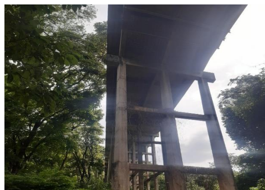
สภาพทั่วไปของโครงสร้างส่วนล่าง
