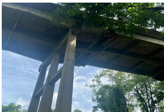
สภาพทั่วไปของโครงสร้างส่วนล่าง
