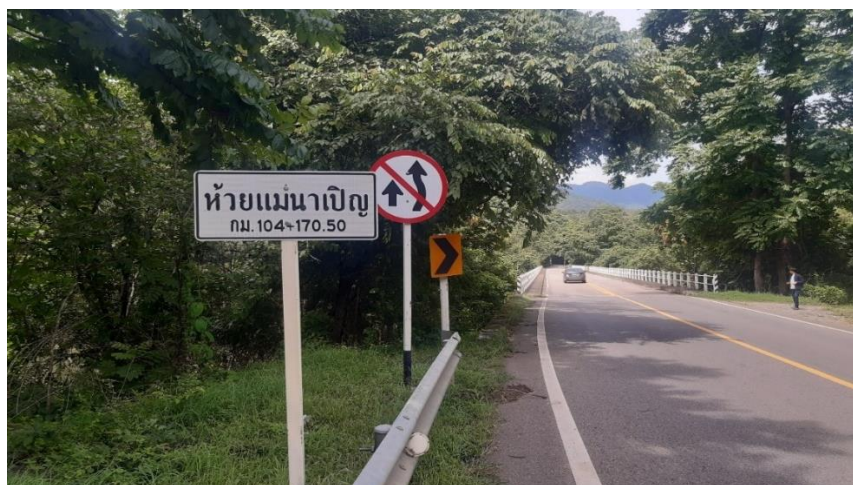
รูปที่ 6-4 สะพานข้ามห้วยแม่नाเปญ
