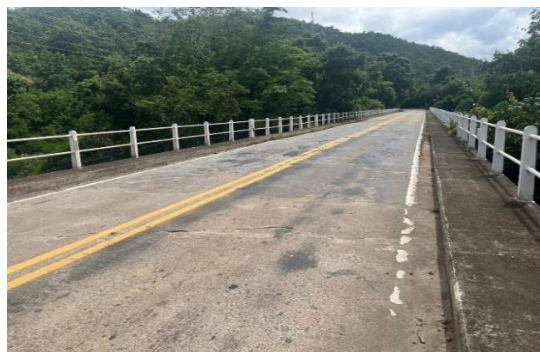
สภาพทั่วไปของสะพานส่วนบน
