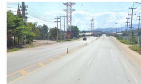
② ทางหลวงหมายเลข 108 (ก่อนพื้นที่โครงการ)
