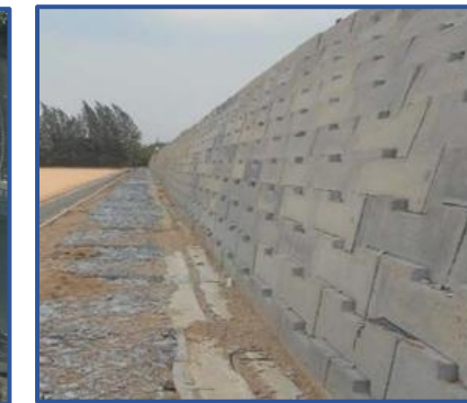
ติดตั้งกำแพงดินเสริมกำลัง (MSE WALL) ช่วง กม.103+934 ถึง กม.104+047 และ กม.104+282 ถึงกม.104+369
