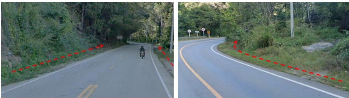
รูปที่ 5-9 สภาพปัจจุบันของระบบระบายน้ำตามยาว
