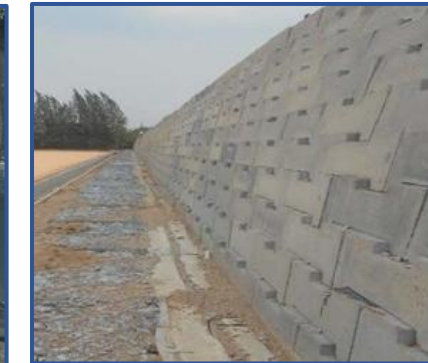
ติดตั้งกำแพงดินเสริมกำลัง (MSE WALL)
