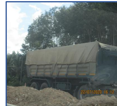
รถบรรทุกอรับเศษดิน ไปยังจุดกองดินที่กำหนดไว้
