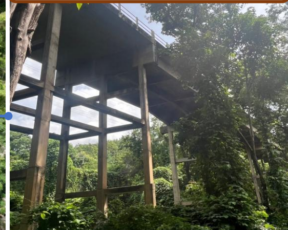
สภาพทั่วไปของโครงสร้างส่วนล่าง
