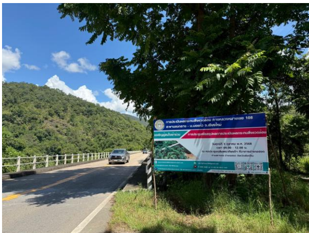
บริเวณ กม.104+170
