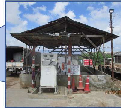
เทพื้นคอนกรีตยกขอบ บริเวณที่เก็บน้ำมัน
